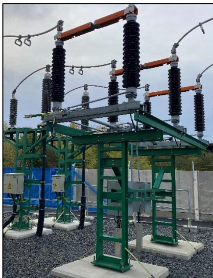
Sepnuté odpojovače
