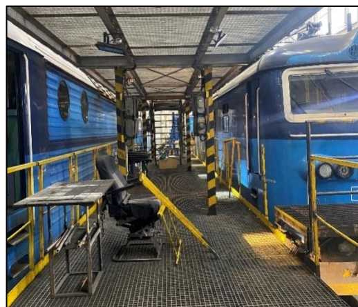
Hala pro údržbu elektrických lokomotiv (nižší stupně oprav)
