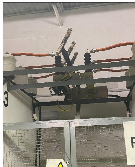
Odpojený odřezávací – PODÉLNÉ DĚLENÍ
