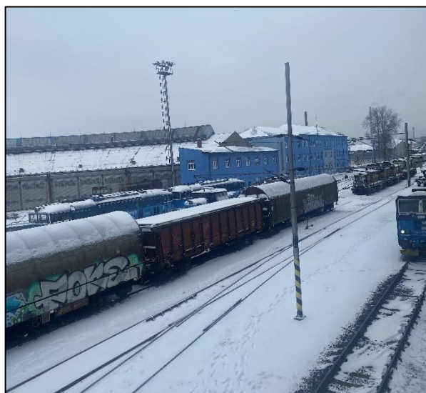
Pohled na depo
