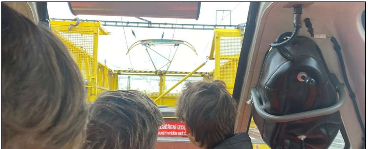
Sběrač při měření klikatosti trakčního vedení
