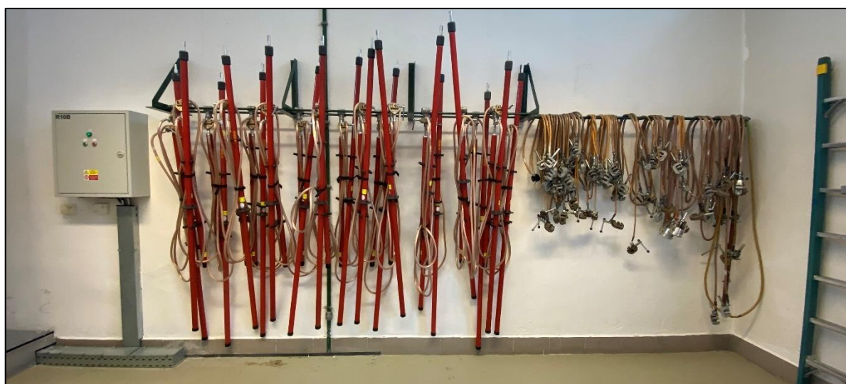
Zkratovací soupravy – na 110 kV AC (vlevo) na 22 kV AC (vpravo)
