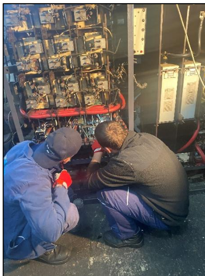
Probíhající oprava měniče
