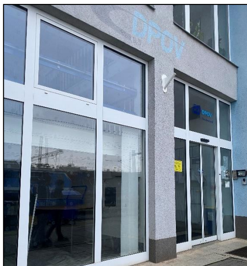
Vchod do DPOV, a. s. v Přerově
