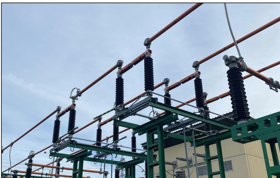
Sepnuté podélné dělení šesti odpojovači
