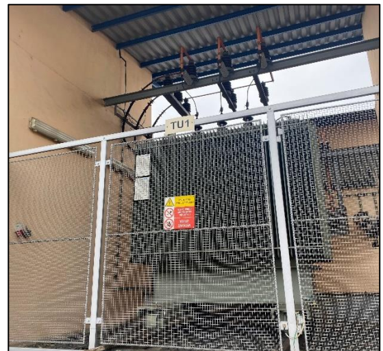
Trakční transformátor – s šesti vývody
