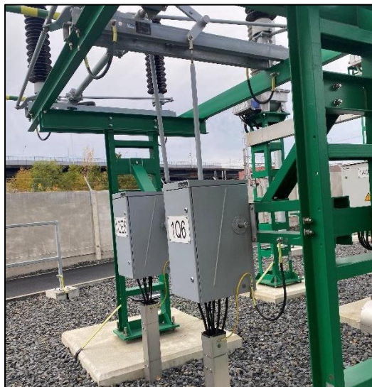
pohony odpojovačů a uzemňovačů
