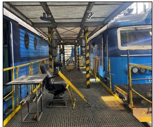
Hala pro údržbu elektrických lokomotiv (nižší stupně oprav)
