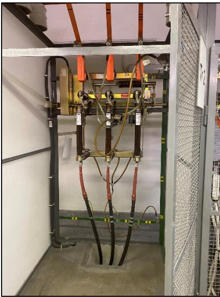
Kobka s jištěním
