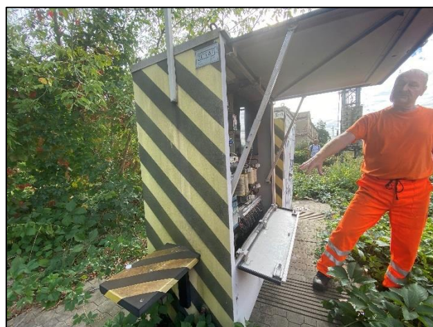
Skříň pro vytápění výměn
