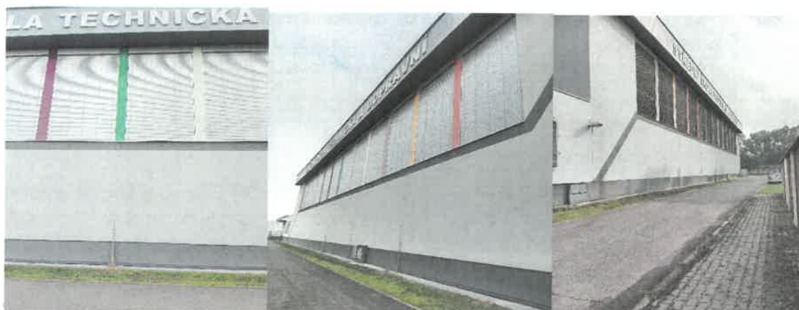
Oprava žaluzií, školy, přízemí – rekonstrukce elektroinstalace
